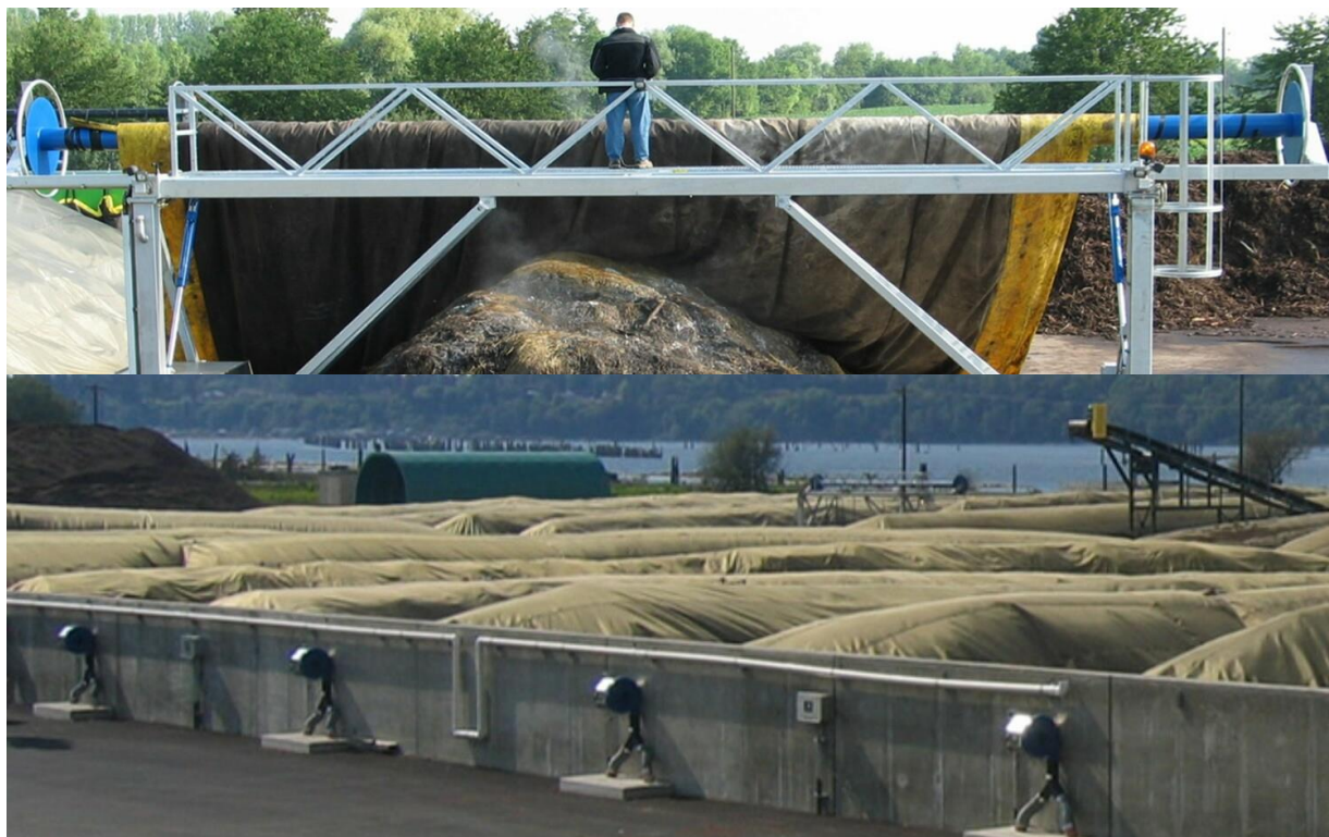
Рисунок 25 – Ламинированное трехслойное буртовое покрытие
